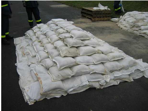
So schaut ein sachgerechter Sandsackdamm im Querschnitt aus: Verhältnis Breite unten zu Höhe ca. 2 : 1
