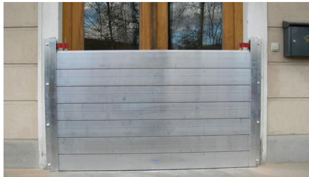
Spundwand inkl. Klemmvorrichtung
